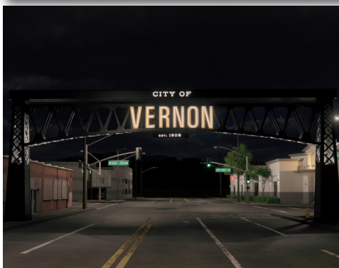
El arco de entrada se está instalando en la intersección de Santa Fe y 25th
